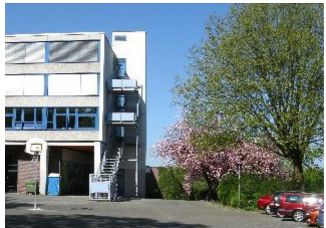
Le bâtiment scolaire
